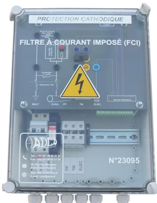
Le Filtre à Courant Imposé est un dispositif permettant d'écouler de façon permanente les courants alternatifs.
