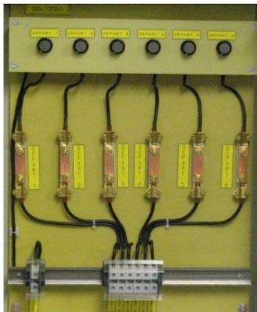
Platine de distribution d'anodes équipée de résistances variables
