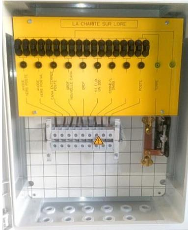
Cette platine possède un éclateur pour la mise à la terre des ouvrage en cas de foudre
