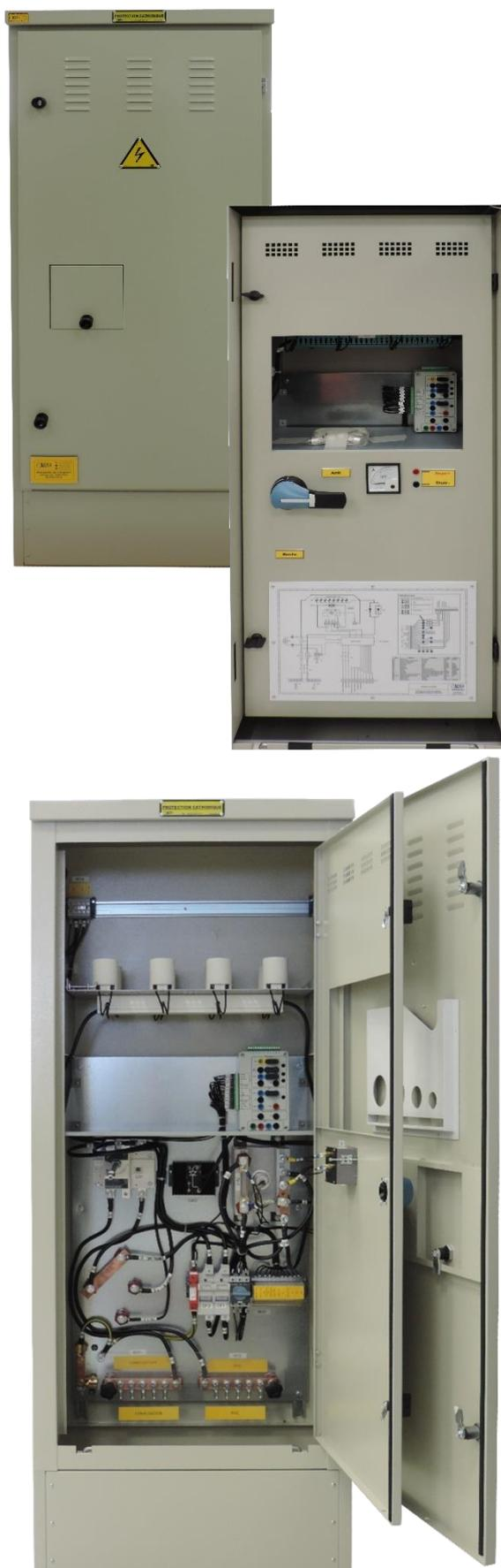
Le poste de drainage se compose de trois parties : partie régulation, partie mesure et contrôle, et partie puissance.
